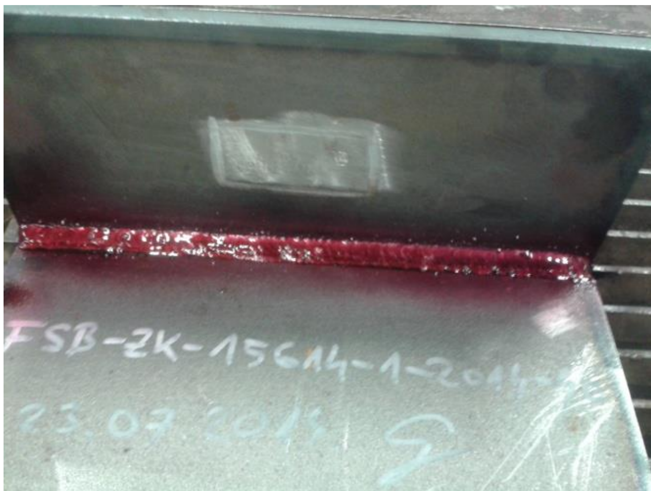
Slika 16. Penetrant na zavaru
