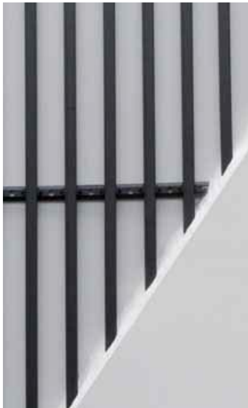
Slika 3.2 Ugradnja registra u žbuku
