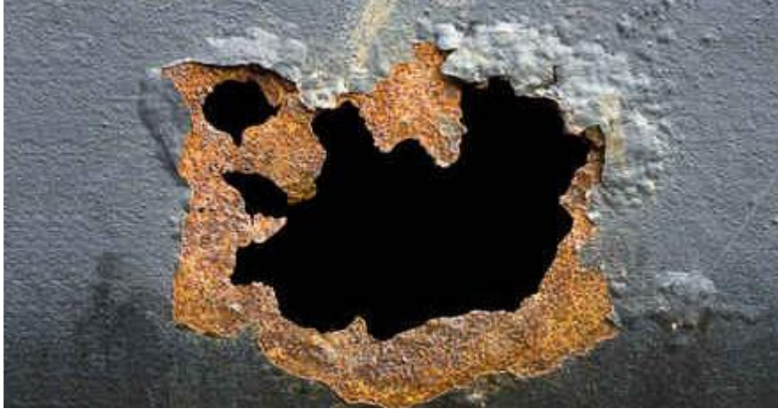
Slika 2. Šteta nastala korozijskim djelovanjem [3]
