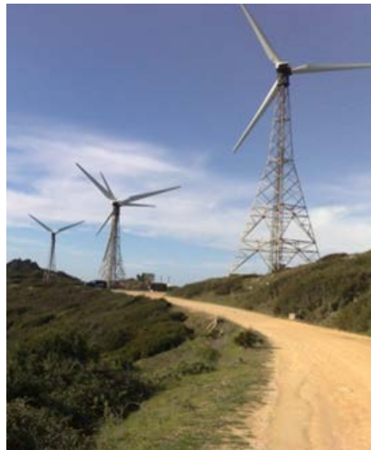
Slika 7 - Rešetkasti stup [9]
