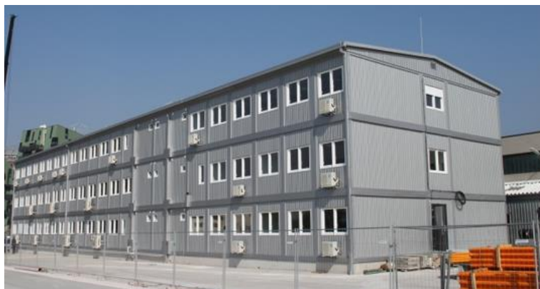
Slika 13. Modularni objekt "Wiener Netze " u Beču
