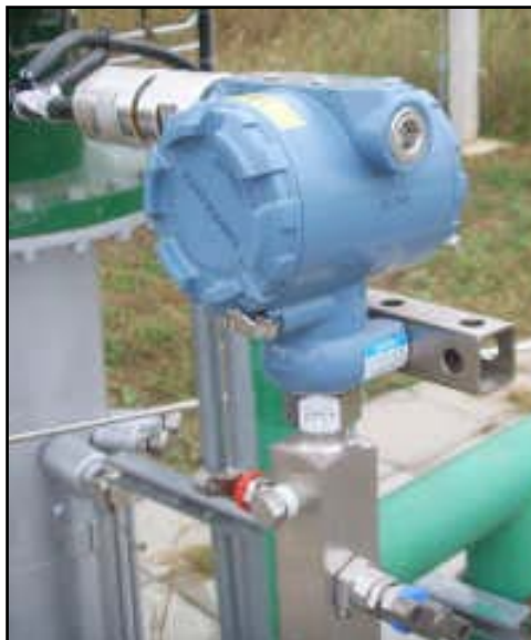
Slika 16. Pretvornik tlaka
