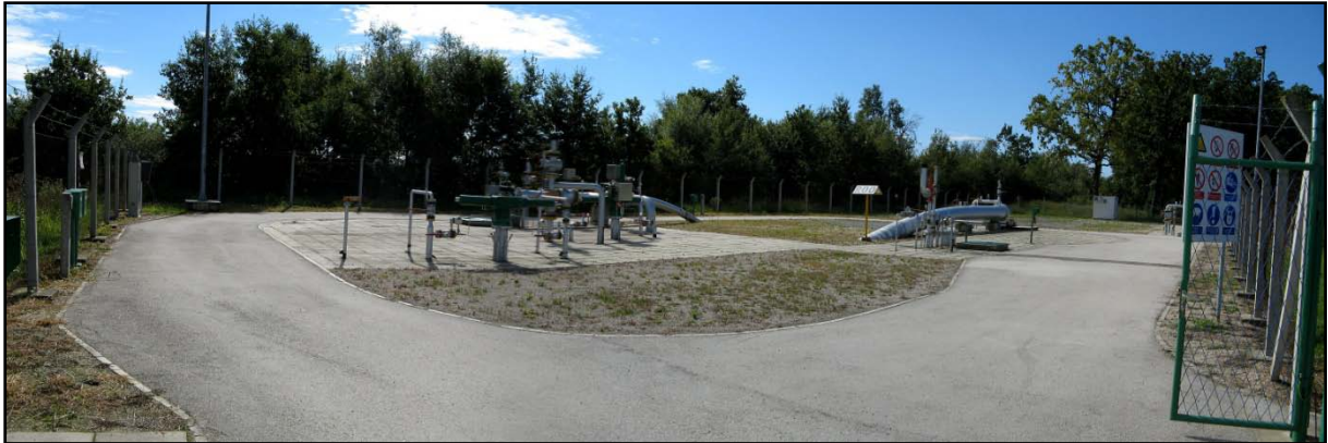
Slika 7. Plinski čvor Draganić – cijeli objekt (5 blokadnih uređaja)
