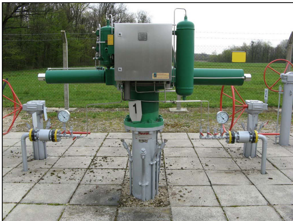
Slika 10. Blokadni uređaj - nadzemni dio
