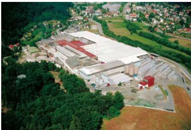
Slika 3: Vetropack Straža tvornica stakla d.d.
