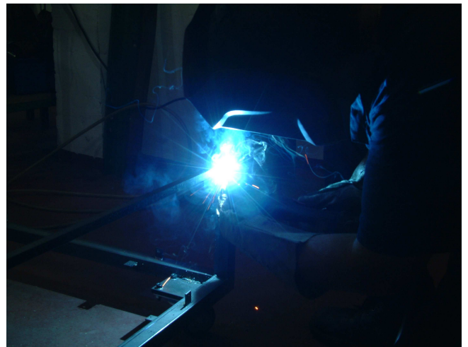
Slika 39. Zavarivanje kućišta MAG postupkom
