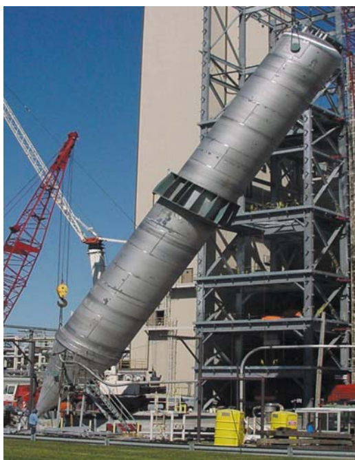
Slika 5.5. Prikaz postavljanja SSP reaktora u SSP postrojenje [32]
