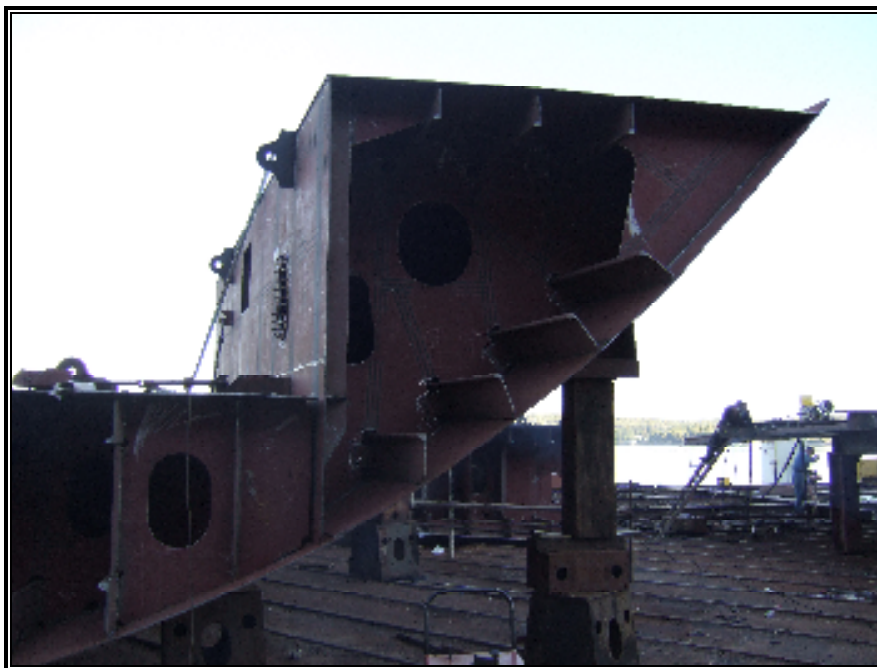
Slika 27. Ukрупnjavanje sekcija
