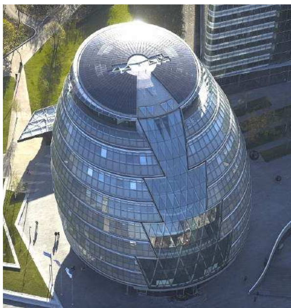
Slika 5. Lijevo: solarni paneli na krovu Londonske gradske vijećnice [5]
