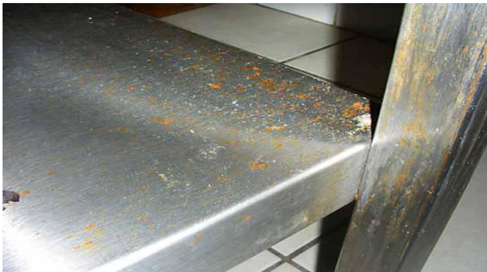
Slika 6. Korozija u kuhinji [10].
