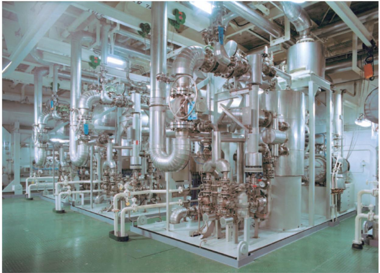
Slika 66: Postrojenje za ponovno ukapljivanje isparenog prirodnog plina na LNG tankeru
