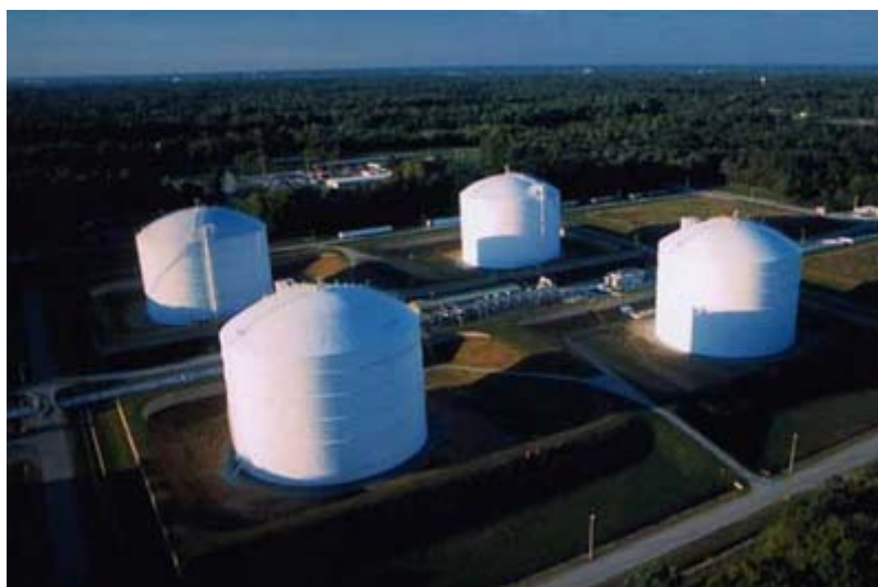
Slika 4: Najveći LNG terminal u SAD-u (Maryland, južno od Baltimorea)
