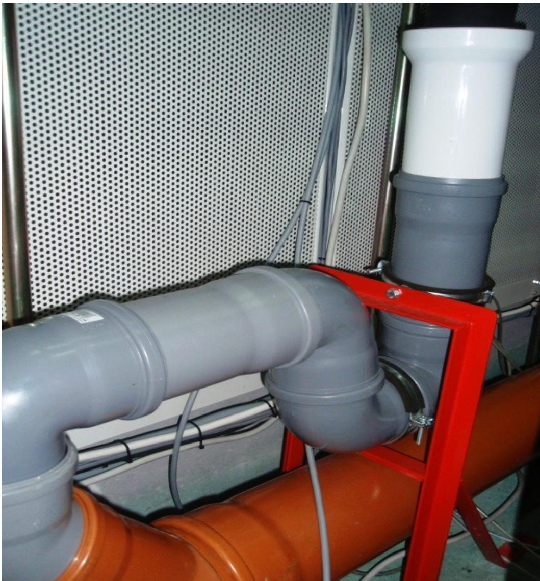
*Slika 4.17. Priključak odvoda iz hidrauličke kočnice u glavnu odvodnu cijev*
