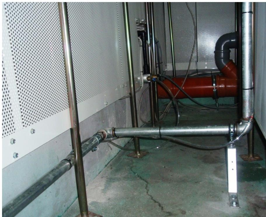
*Slika 4.8. Razvod hidrauličke instalacije do ulaza u kočnicu*
