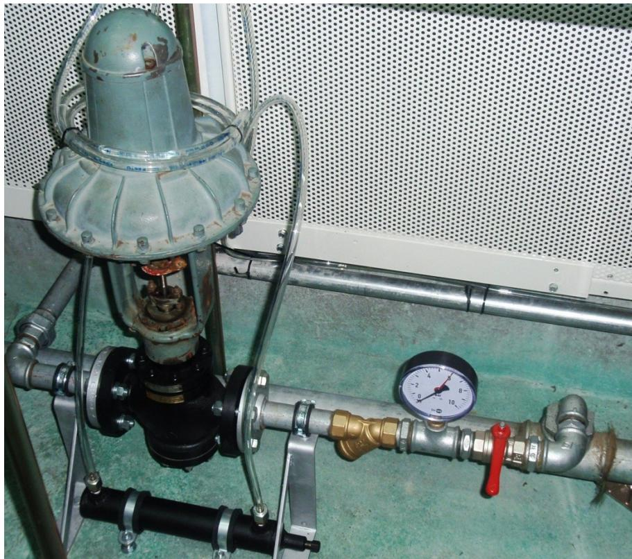
*Slika 4.7. Priklučak hidrauličke kočnice na vodovodnu instalaciju*
