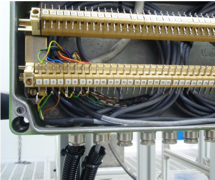
*Slika 4.20. Prikaz spajanja vodiča u razvodnoj kutiji*
