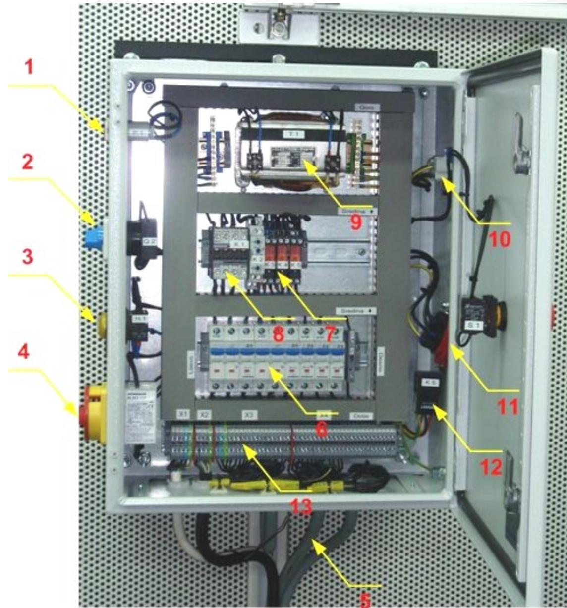
1 – brojač radnih sati ispitnog motora; 2 – upravljački prekidač sustava hlađenja ispitnog motora; 3 – kontrolna lampica niskog napona; 4 – glavna sklopka; 5 – priključni vodovi; 6 – automatski osigurači; 7 – upravljački releji; 8 – motorni sklopnik; 9 – transformator 220 V / 24 V (50 Hz); 10 – jednofazna utičnica za ispitnu kabinu; 11 – trofazna utičnica za ispitnu kabinu; 12 – relaj za pokretanje ispitnog motora; 13 – redne stezaljke
