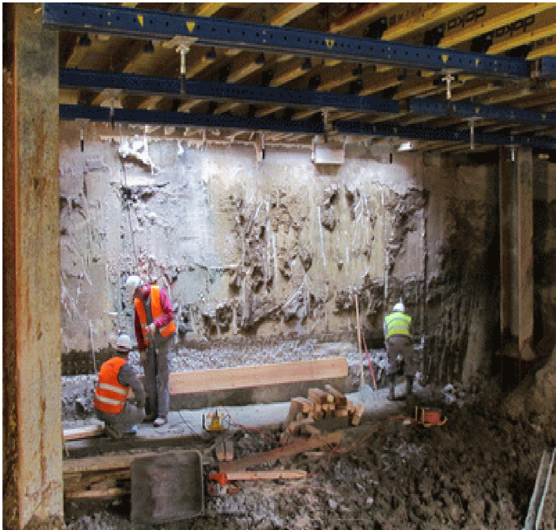
Slika 3.1 Radnici unutar iskopa
