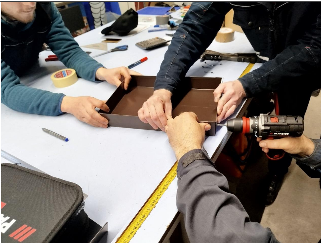
Slika 46. Bušenje rupa za zakovice.
