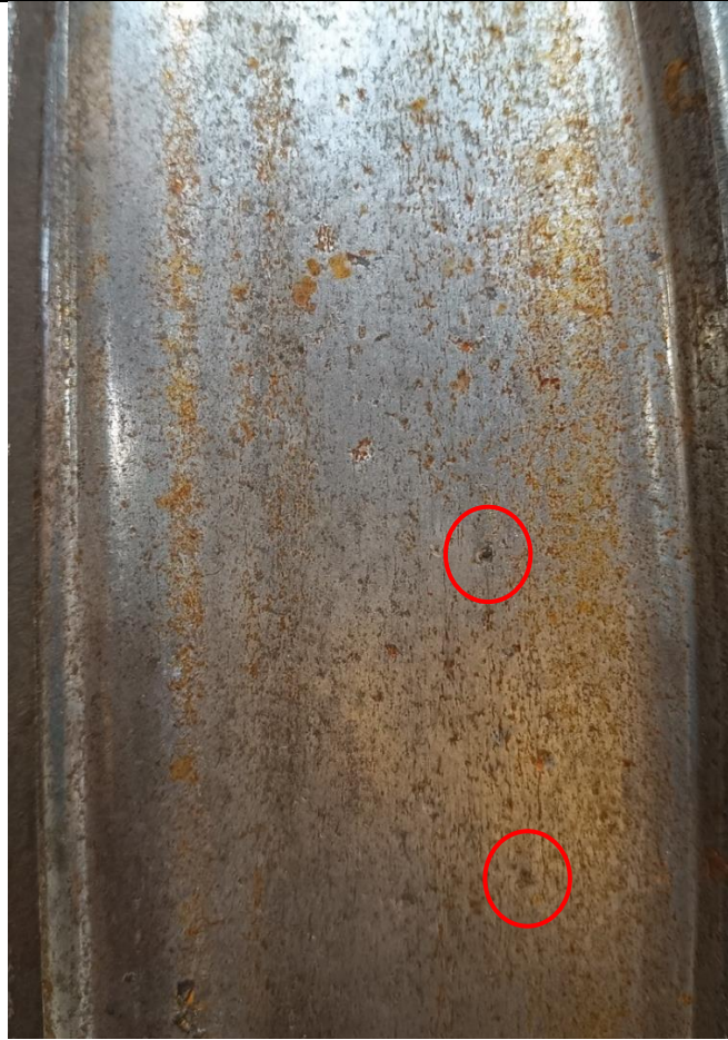
Slika 15. Jamice nastale rupičanjem (engl. spalling )
