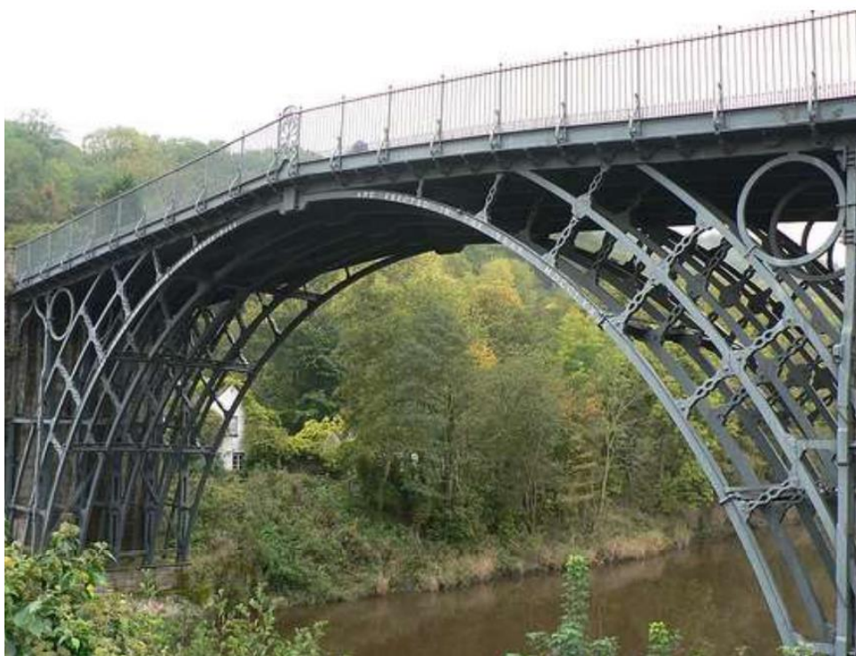
Slika 2.3 Prvi odliveni željezni most Iron Bridge u Engleskoj [2]
