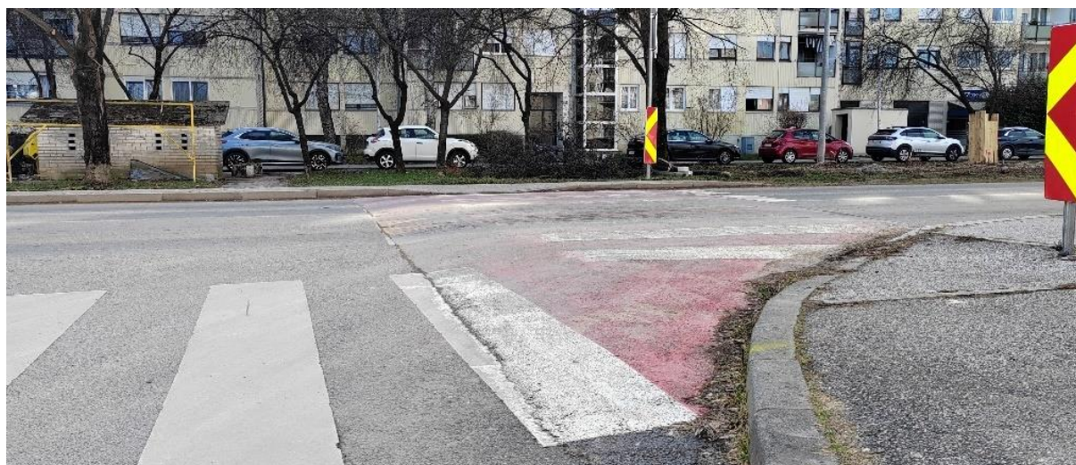
Slika 72. Izgled izvedenog uspornika na kolniku, Sarajevska cesta
