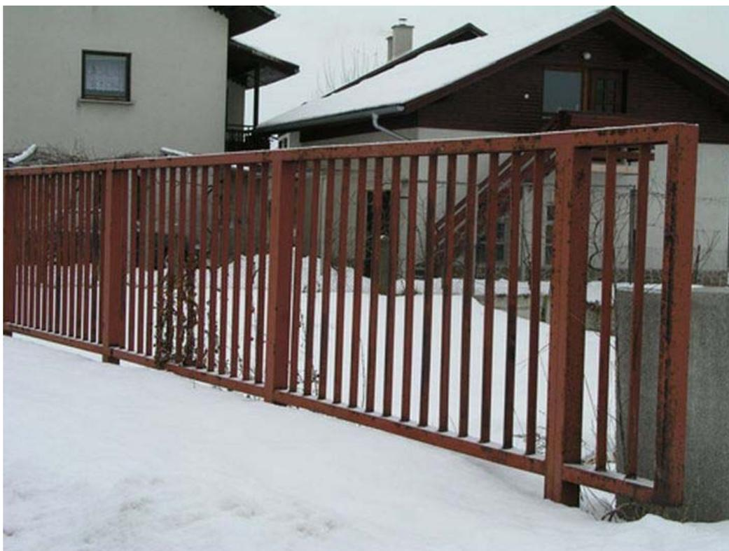
*Slika 4.1. Pojava korozije na metalnoj ogradi*
