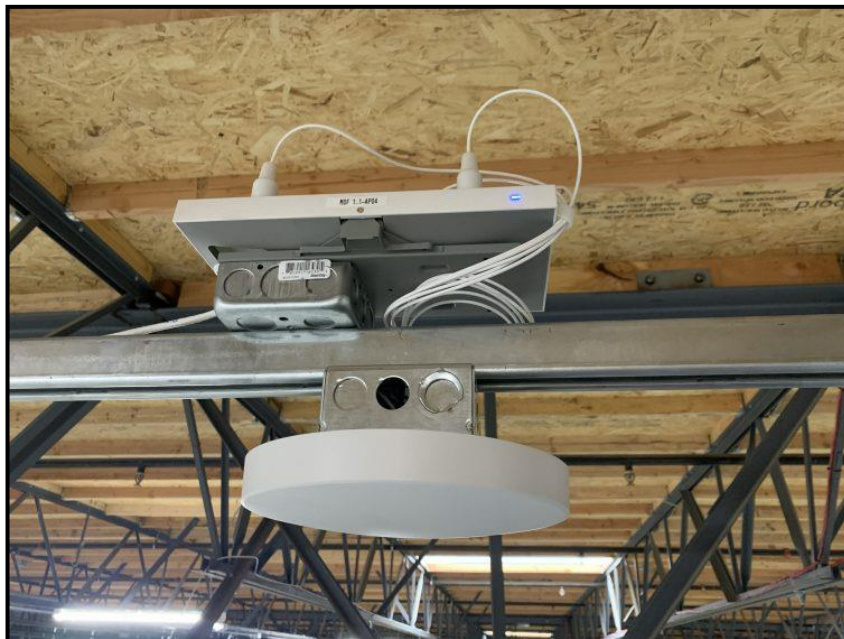
Slika 5. Montiranje Wi-Fi antena (Access Points) [22]
