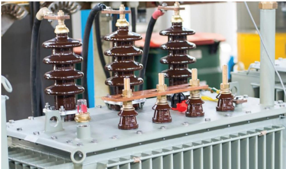
Slika 24. Priključci transformatora unutar vakuumske komore
