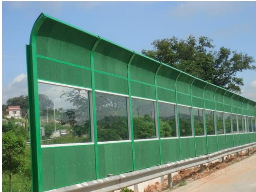
Slika 36 – Aluminijске pjene za apsorpciju zvuka, obojane otpornije na koroziju [12]
