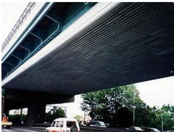
Slika 35 – Konstrukcija od aluminijske pjene za apsorpciju zvuka i vibracija na nadvožnjaku
