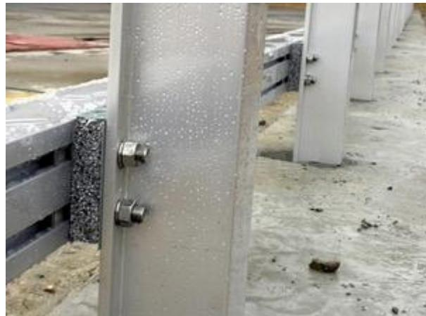
Slika 32 – Primjena aluminijске pjene kao elemenata za apsorpciju energije [12]
