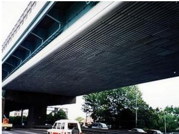
Slika 35 – Konstrukcija od aluminijiske pjene za apsorpciju zvuka i vibracija na nadvožnjaku
