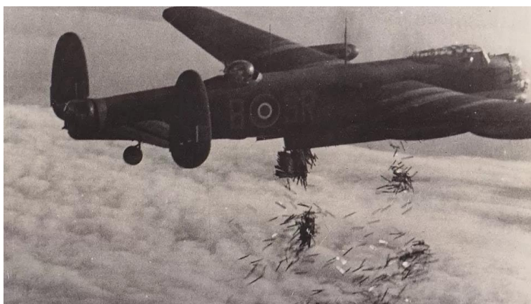
Slika 25 Britanski zrakoplov Lancaster raspršuje dipolne reflektore
