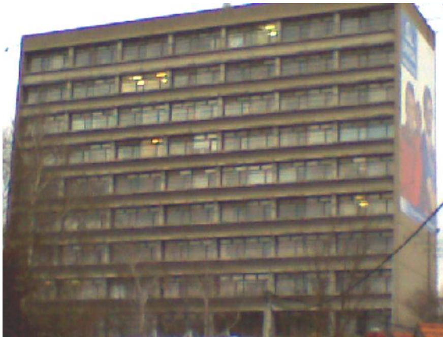
Slika 3. Južna zgrada Fakulteta strojarstva i brodogradnje
