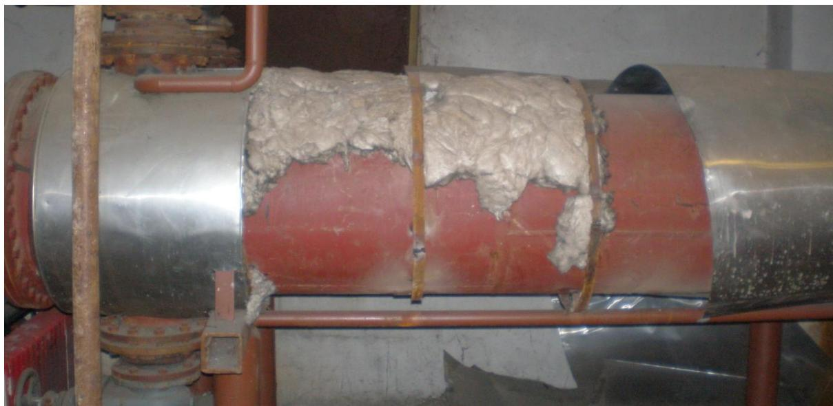
Slika 10. Izmjenjivač topline u podsustavu proizvodnje
