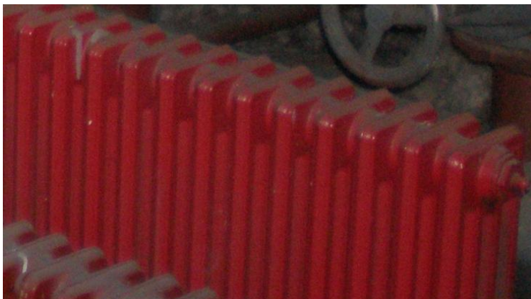
Slika 12. Radijatori u podsustavu predaje topline
