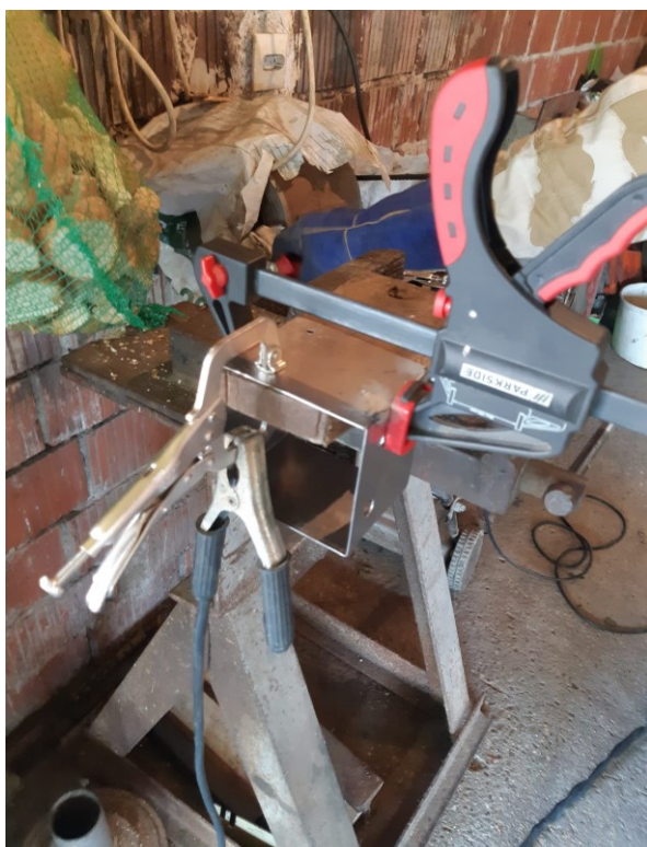
Slika 3.23 Priprema za zavarivanje
