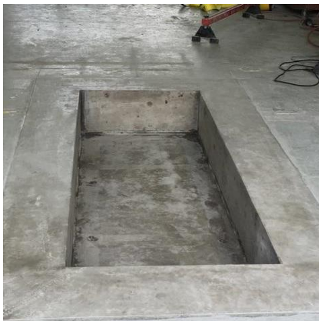
Slika 10. Primjer ugradbenog bazena za ukopanu podiznu platformu
