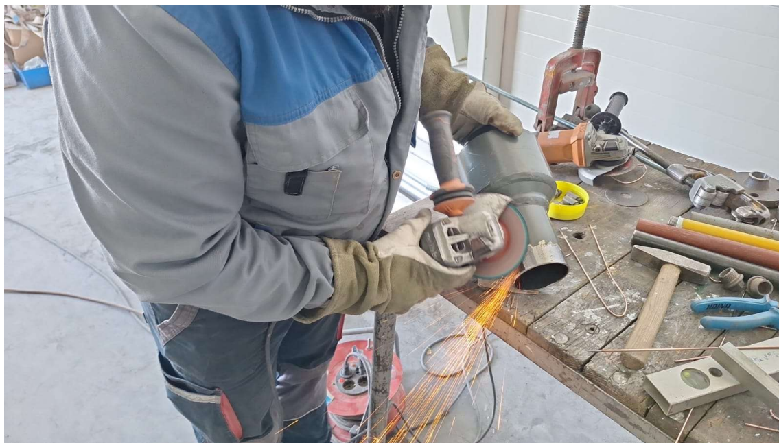
Slika 19. Priprema tijela ventila za zavarivanje
