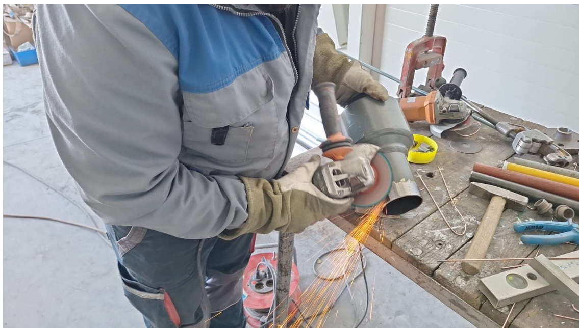
Slika 19. Priprema tijela ventila za zavarivanje
