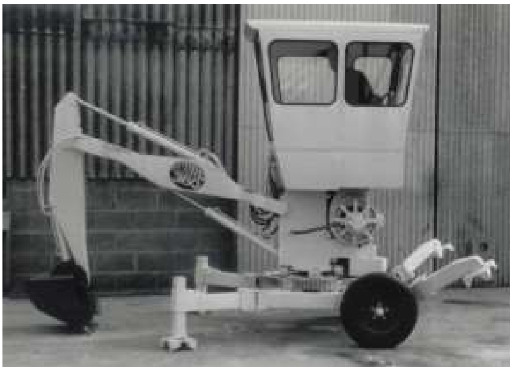
Slika 6. Smalley 360/5 , prvi mini bager [12]
