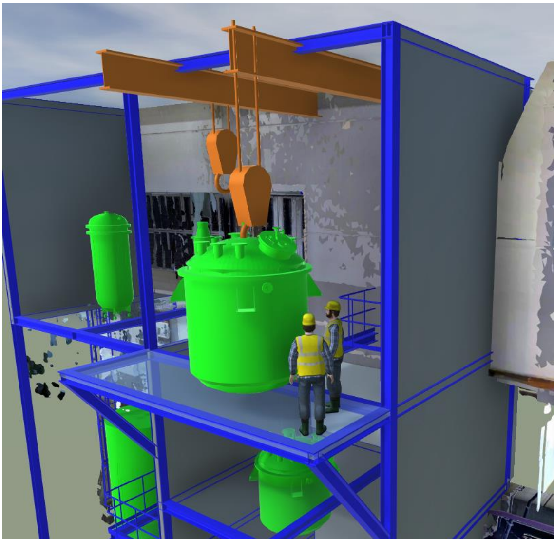
Slika 65. Pričvršćivanje reaktora na stropnu dizalicu
