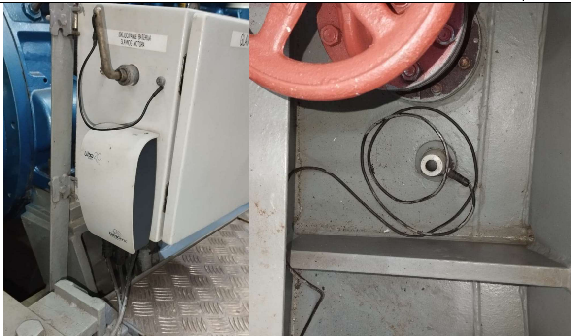
Slika 25. Sastavni dijelovi ultrazvučnog sustava zaštite
