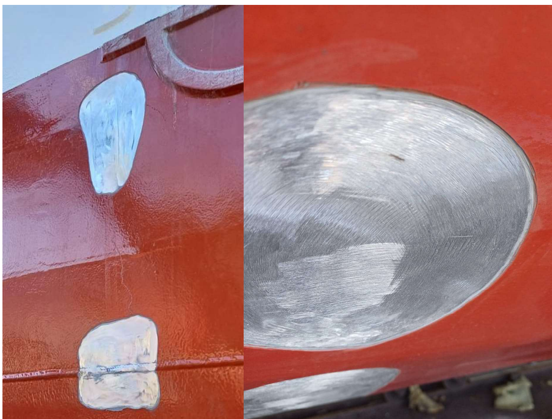
Slika 20. Priprema površine za lokalno obnavljanje silikonskog premaza
