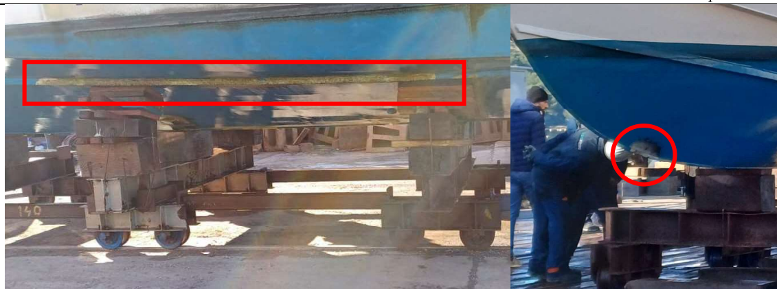
Slika 17. Otpadanje zaštitnog premaza po boku broda i početak obraštavanja izloženog dijela oplata dijela (lijevo) i oštećenje premaza na pramcu u području centralne linije broda (desno)
