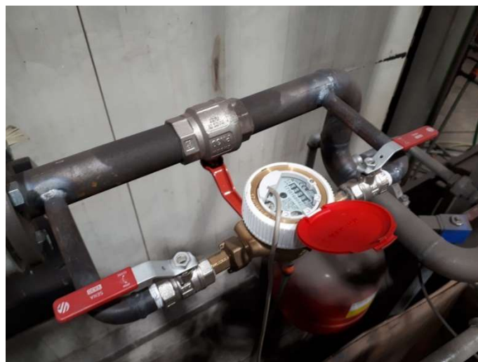
Slika 33. Turbinski protokomjer
