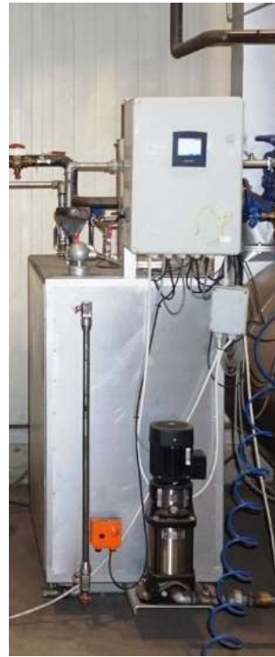
Slika 21. Kondenzni spremnik
