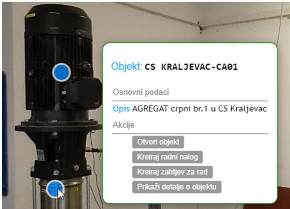
Slika 33. Prikaz sadržaja prozora interaktivne točke crpnog agregata
