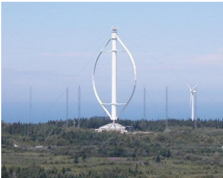
Slika 1.11 Darrieusov rotor [E]
