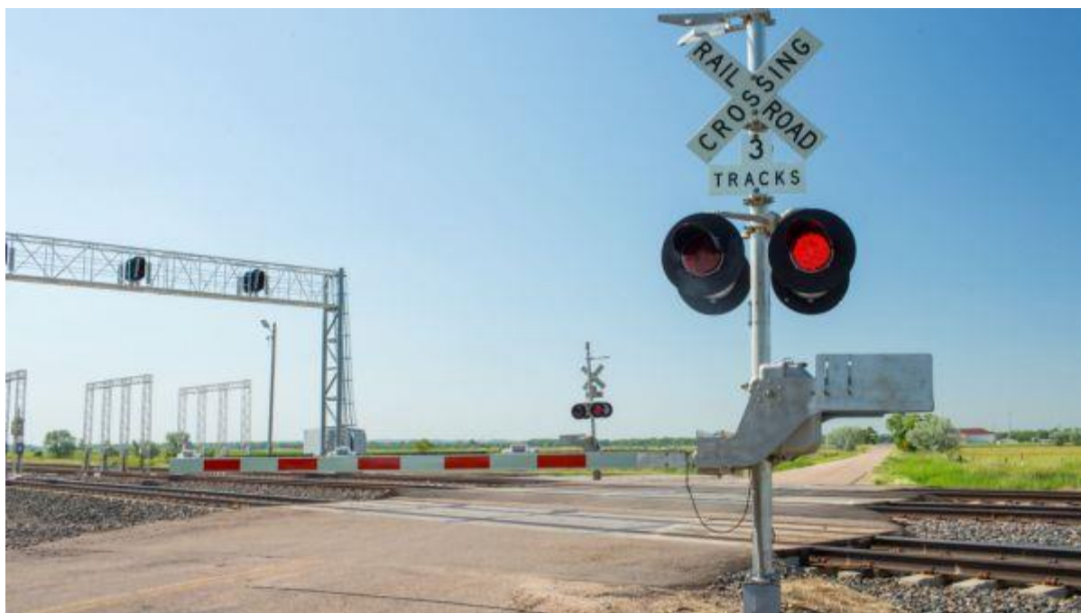
Slika 7. Željeznički prijelaz sa branikom S – 60
