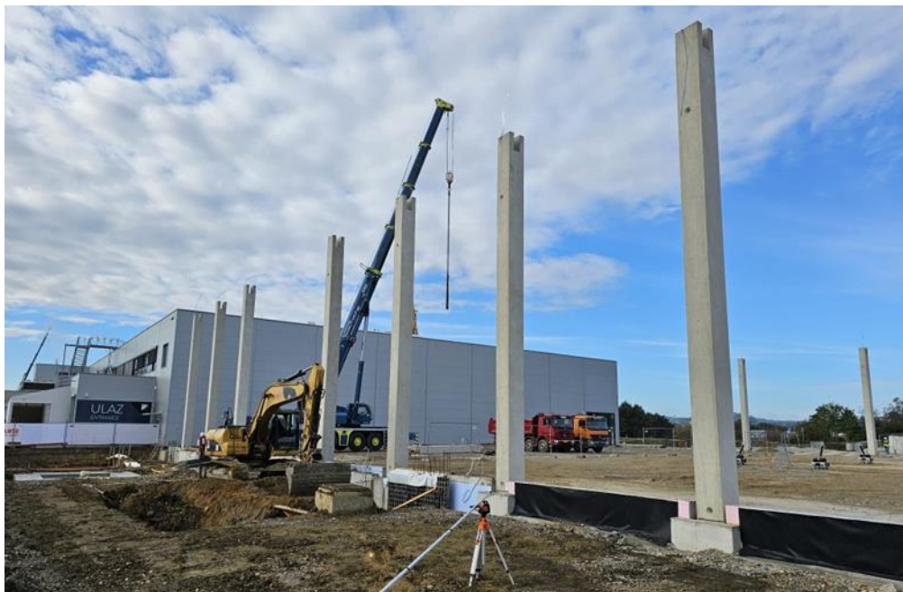
Slika 24. Izgradnja nove hale
