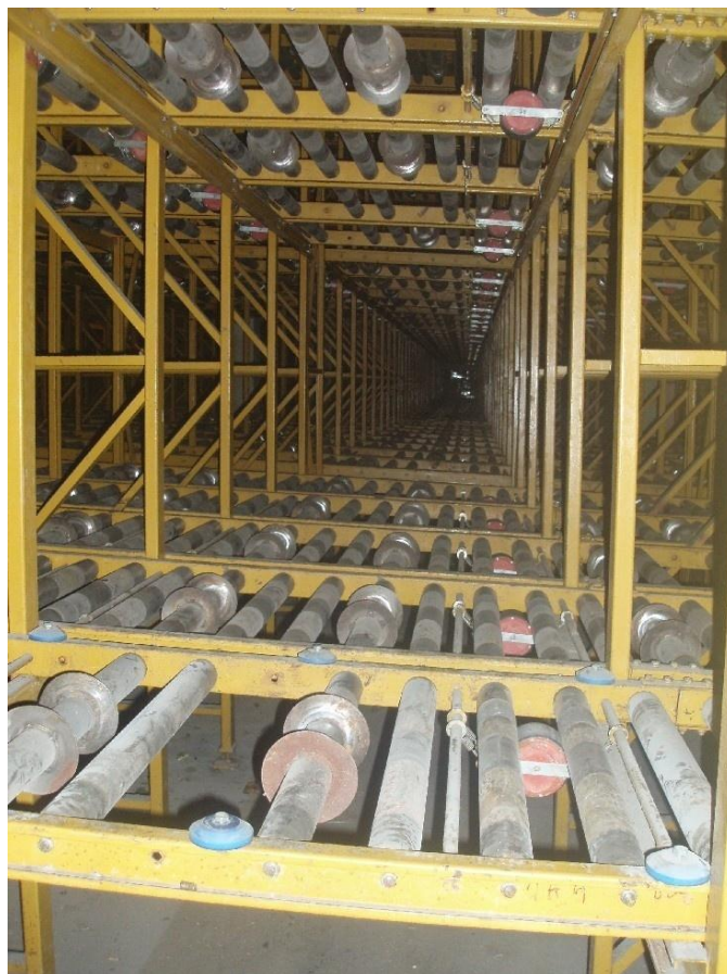
Slika 19. Tuneli u skladištu
