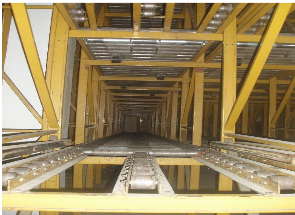
Slika 20. Tuneli valjčanih traka u skladištu
