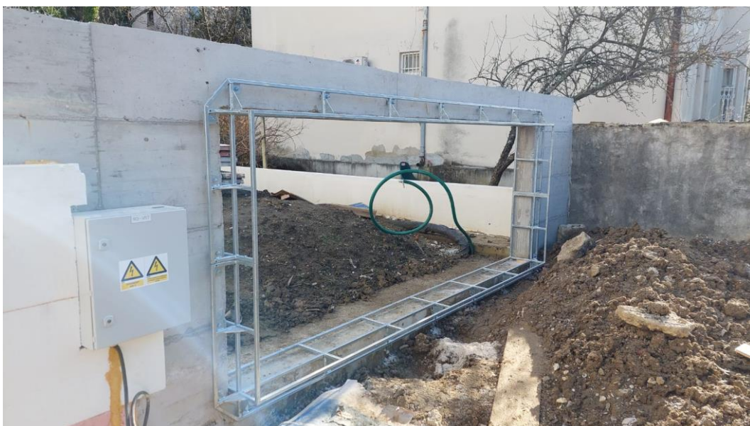
Slika 26. Prikaz montirane konstrukcije
