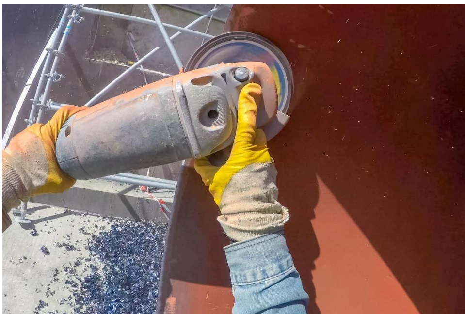
Slika 14. Čišćenje površine rotacijskom četkom [26]
