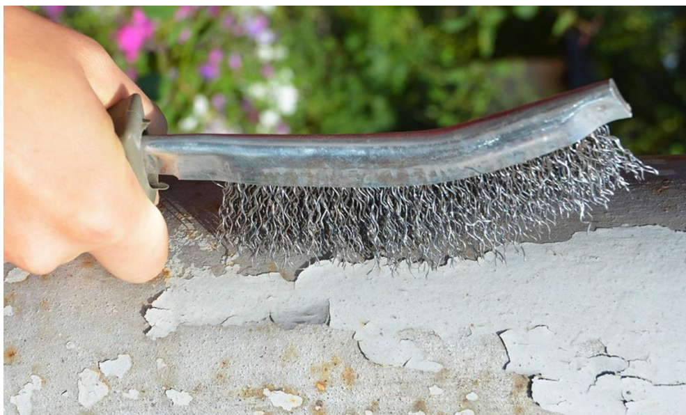
Slika 13. Čišćenje površine četkom [26]
