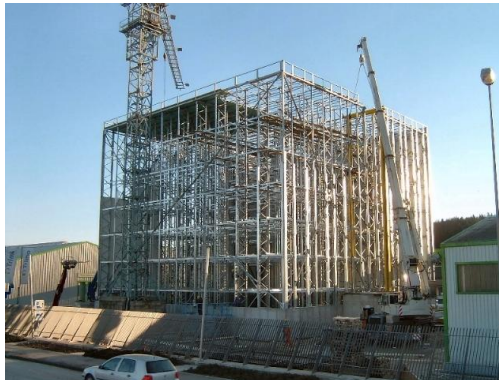
Slika 2.4. Visokoregalno skladište [5]
