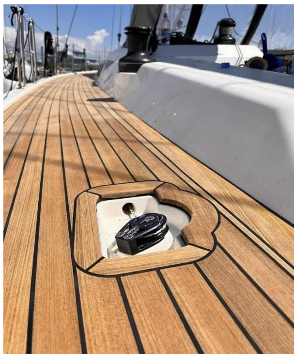
Slika 24. Dio montirane palube od tikovine
