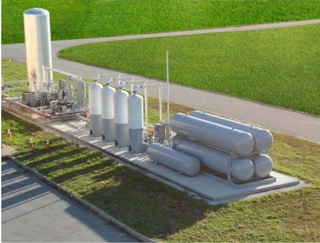
Slika 5: Postrojenje za pročišćivanje bioplina uz pomoć PSA tehnologije [23]
