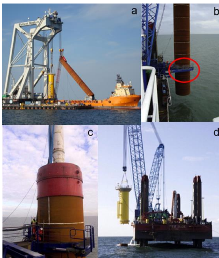
Slika 43. Prikaz ugradnje pilotnog temelja [22]
