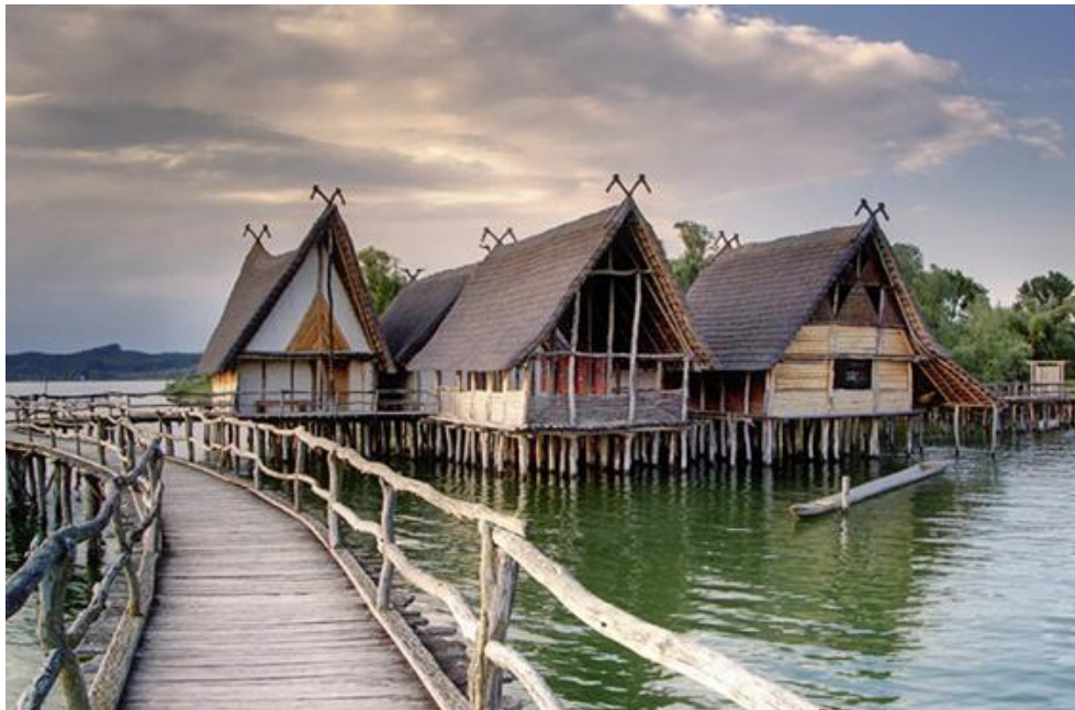
Slika 2. Sojenice s drvenim pilotima [3]
