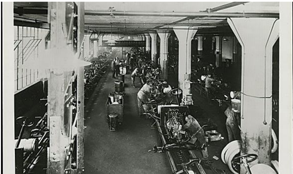
Slika 3. Montažna linija u Fordu, vrijeme montaže motora Modela T smanjeno je s 594 minute na 224 minute [5]
