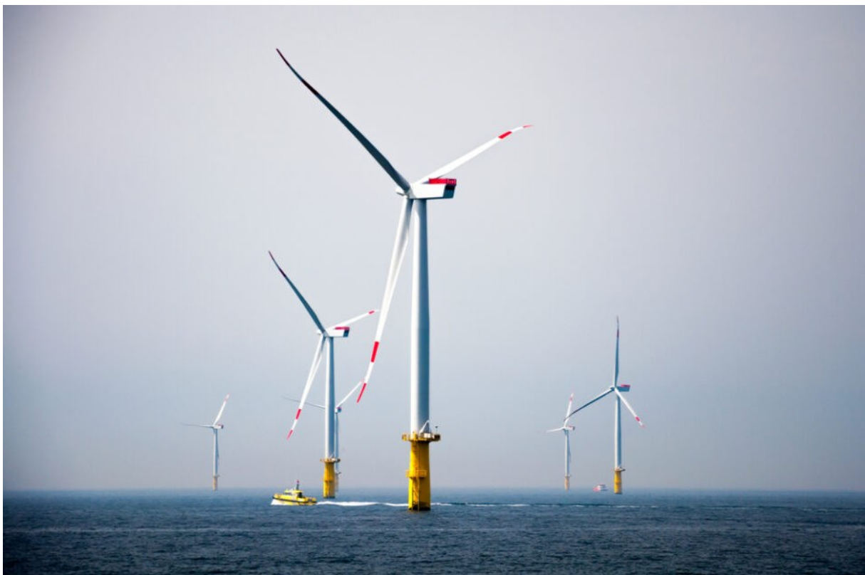
Slika 1. Vjetroelektrane na pučini mora
