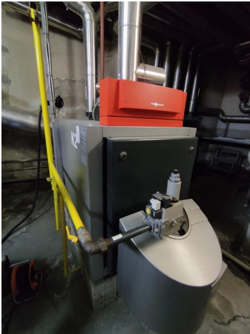
Slika 3. Toplovodni kotao proizvođača Viessmann (tip Vitoplex 200)
