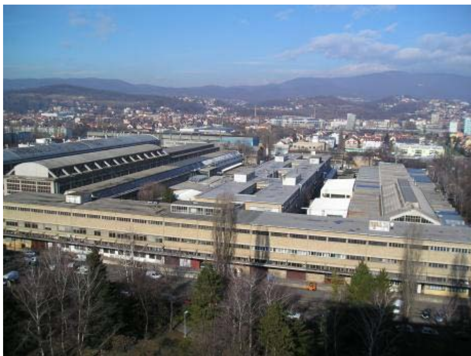
Slika 2.1 Proizvodne hale Končar MES na lokaciji Trešnjevka, Zagreb
