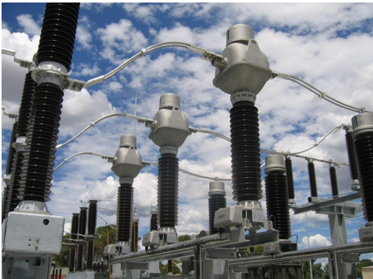
Slika 2.10 Strujni transformator – AGU [19]
