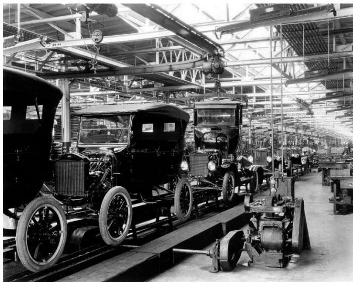
Slika 1. Pokretna traka u tvornici Forda početkom 20. stoljeća [3]
